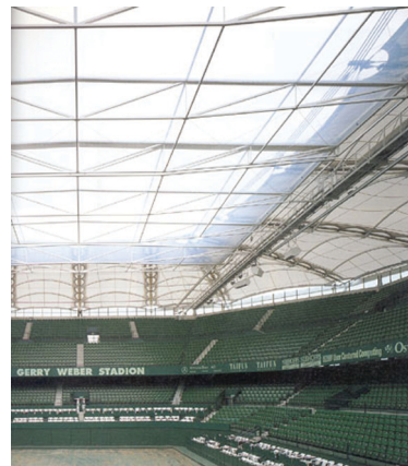
Илл. 9. Крыша теннисного корта Gerry Weber, Halle, Германия, 1994
