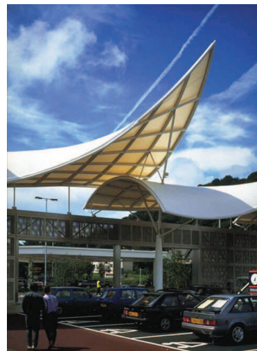
Рисунок 1. Торговый центр Sainsbury Store, Плимут, Великобритания, 1994
