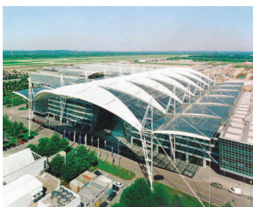
Рисунок 8. Крытие здания Центра управления аэропорта, Мюнхен, Германия, 1999
